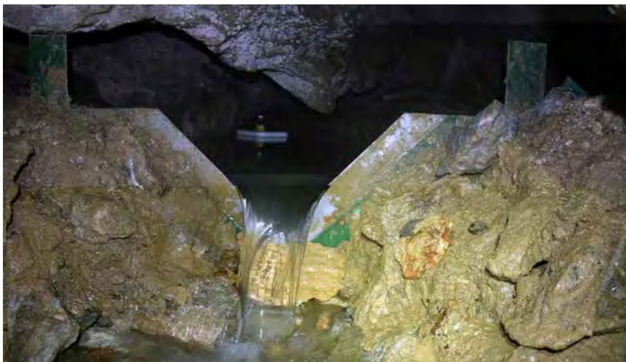
Fig. 12 – Stazione di misura presso l’apporto a sifone in sinistra idrografica, nel testo identificato anche con il termine “apporto a sifone” (foto S. Zauli).
