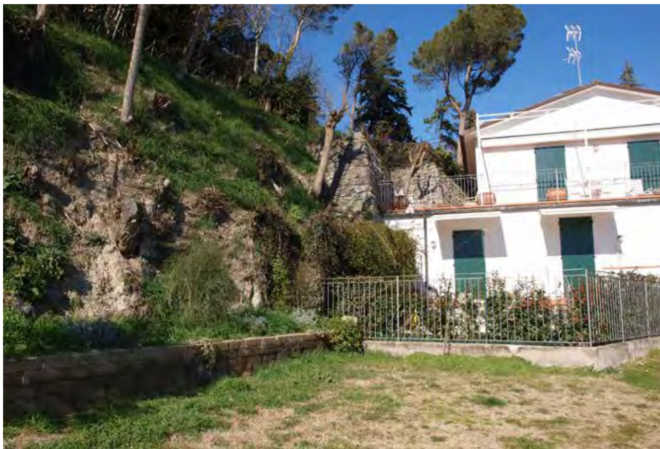
Fig. 21 – L'aspetto odierno del sito della cava e della fornace da gesso dette di Tugnò , attive a Tossignano, nei pressi dell'attuale via Panoramica, tra fine XIX e inizi XX secolo (foto S. Piastra).
