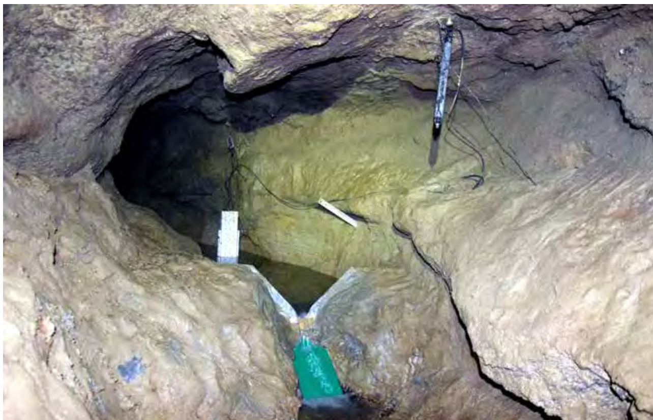
Fig. 11 – Stazione di misura presso l’apporto a sifone in destra idrografica: tale apporto nel testo verrà identificato con il termine “apporto a cascatella” per il caratteristico salto che le acque fanno prima di congiungersi con l’apporto di sinistra idrografica. In primo piano, in alto, è ben visibile il datalogger per la misura del livello dell’acqua contenente il sensore per la misura della pressione barometrica; in secondo piano si può notare il “tubo di calma” contenente la sonda di misura della pressione idrostatica utilizzata dal datalogger che misura il livello dell’acqua e la sonda per la misura della conducibilità elettrica. La temperatura è rilevata da entrambe le sonde contenute nel “tubo di calma” (foto S. Zauli).
