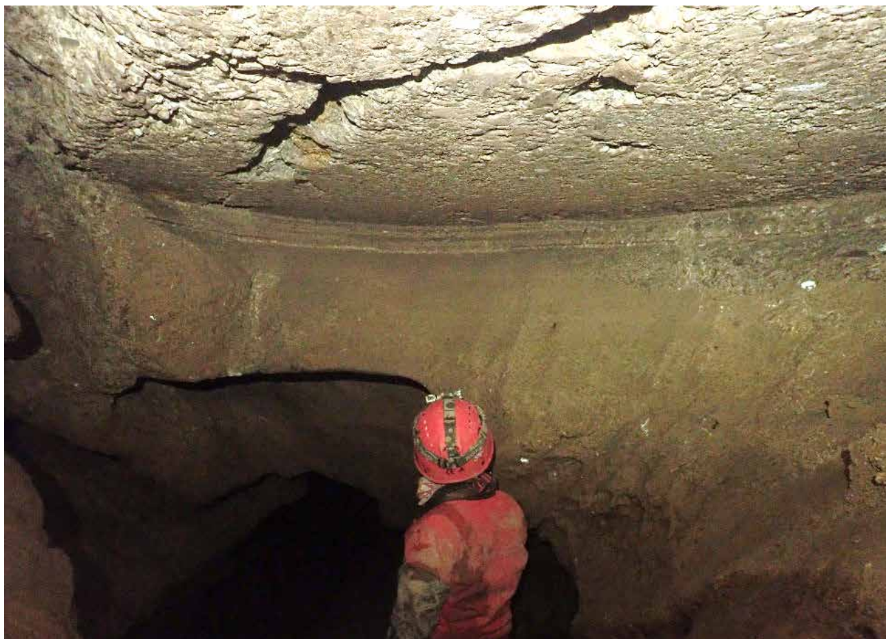
Fig. 5 – Soffitto piatto e livello di stazionamento nel collettore di Ca' Siepe dall'ingresso di Ca' Calvana (foto K. Poletti).
