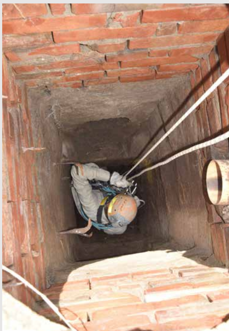
Fig. 3 — Pozzetto artificiale di cattura delle acque (foto S. Zauli).
